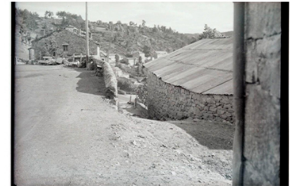
Rue de la rampe
